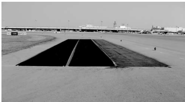
写真一2 表面処理工法試験施工状況
