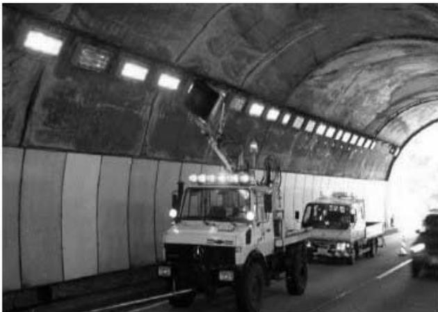
図一 1 トンネル照明器具の清掃状況
