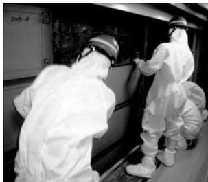
写真-5 囲い込みパネル撤去状況
