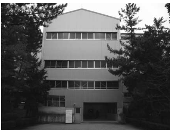
写真—11 東面搬入口
