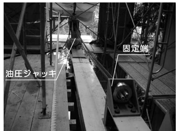
写真—7 固定端取付状況
