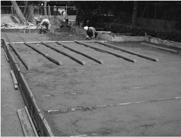
写真—5 基礎解体用ボイド
