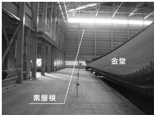
写真—1 素屋根内部状況
