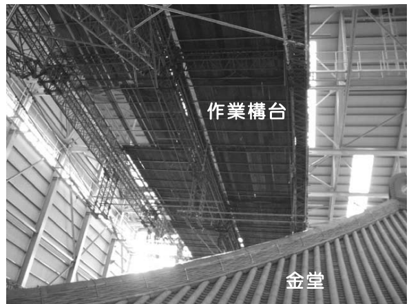
写真一4 作業構台
