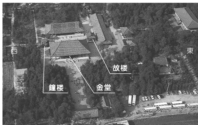
写真—2 素屋根外観（南面手前が金堂）
