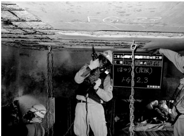
写真一八 はつり作業状況
