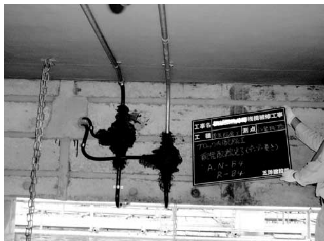
写真-11 配線の完了
