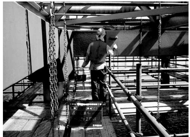
写真—6 表面被覆施工状況
