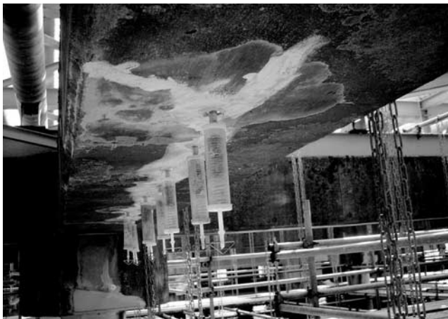
写真—5 ひび割れ注入状況
