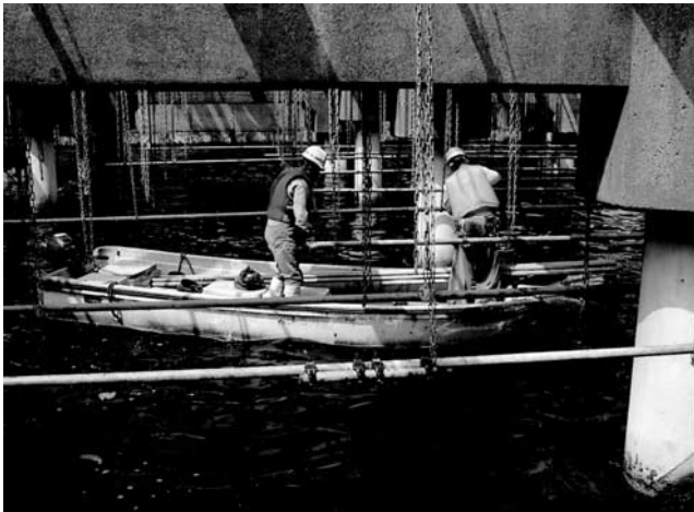
写真—4 足場仮設状況
