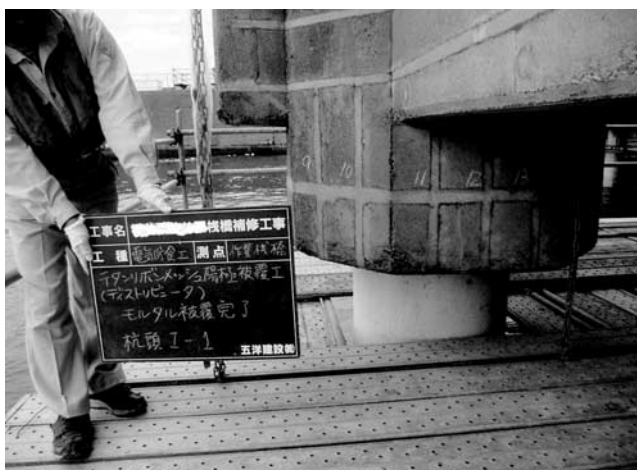
写真-10 陽極設置完了
