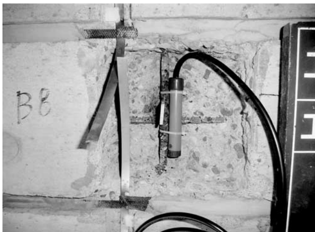
写真-9 照合電極の設置状況
