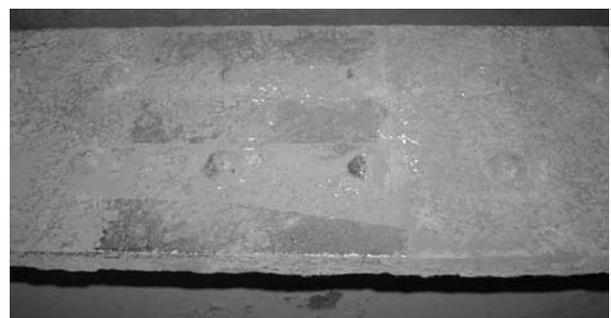
写真—6 下地処理完了
