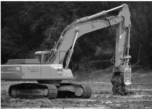
写真—2 トレンチャーによる初期固化状況
