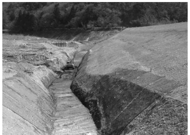
写真一九 止水トレンチの掘削状況
