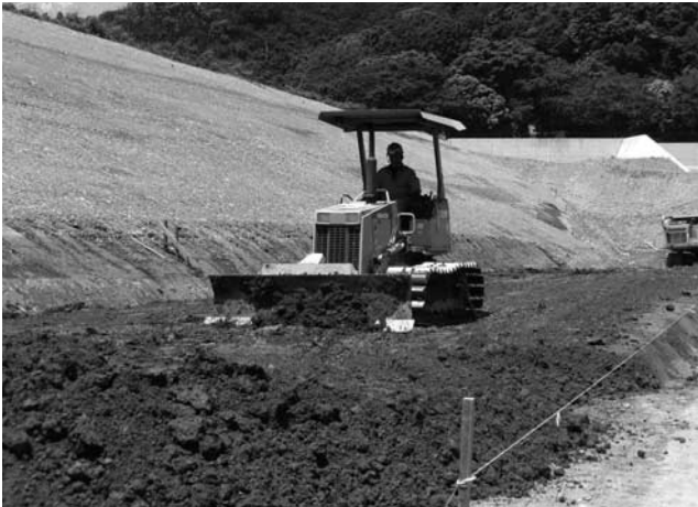
写真一五 解砕土のブルドーザによる敷均し
