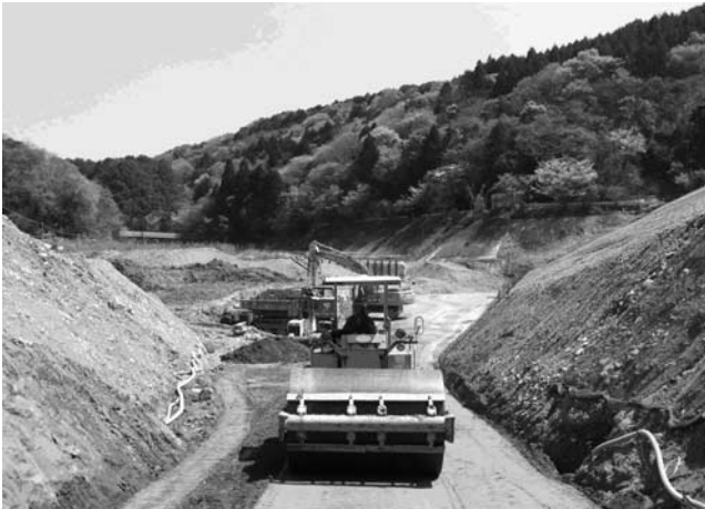
写真一10 コアゾーンI (止水トレンチ部) の築堤状況
