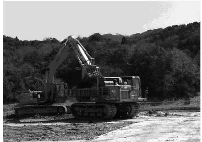
写真—3 バケット式解砕機による解砕状況
