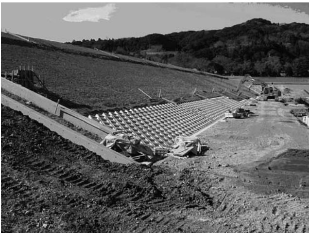
写真一12 張りブロック工の施工状況
