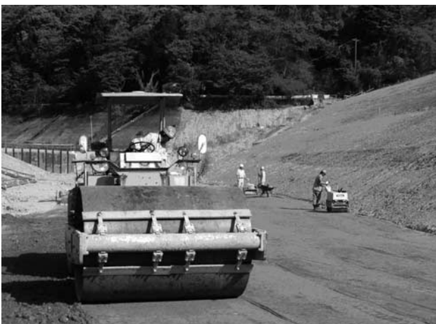
写真一六 振動ローラによる転圧
