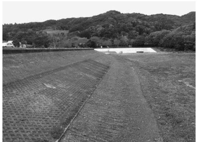
写真一七 改修前の既設堤体の状況
