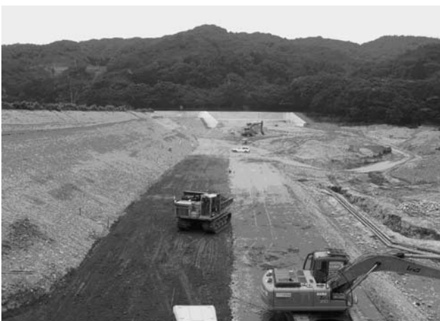
写真一11 コアゾーンIIとランダムゾーンIIIの築堤状況
