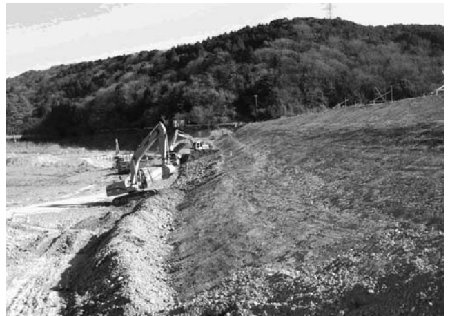
写真一八 既設堤体表層部の掘削状況
