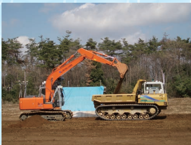
⇩ IT 施工システムによる自律掘削・積込試験状況 (2)
