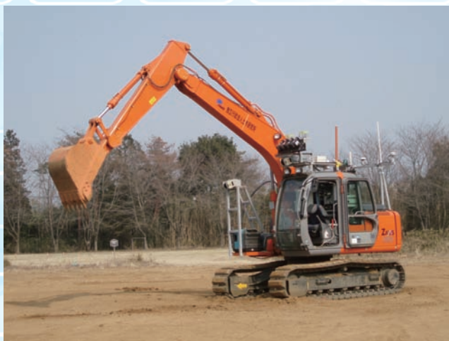
⇩ IT 施工システム (全景)
