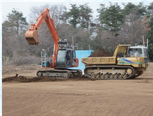
⇩ IT 施工システムによる自律掘削・積込試験状況 (1)
