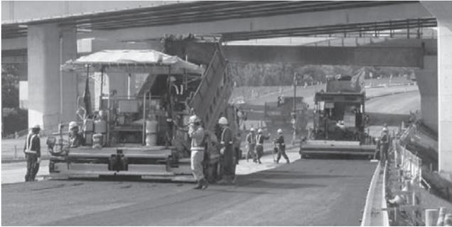
写真—8 3D-MC のフィニッシャへの応用
