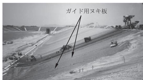
写真一 2 法面に設置されたヌキ板
