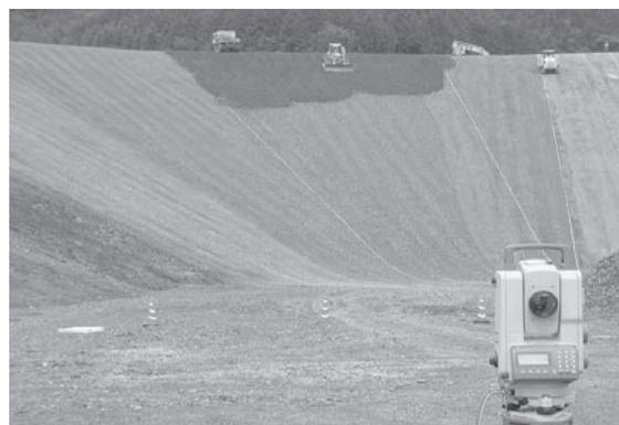
写真一 3 TS-3D-MC ブルドーザの施工状況
