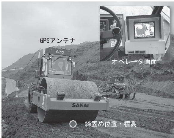
写真1 GPS搭載振動ローラ
