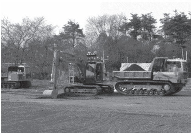
写真-2 掘削積込状況
