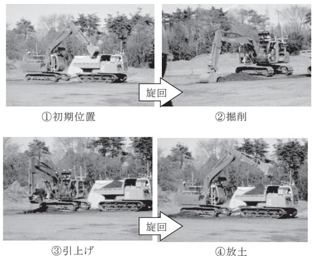
図一〇 一連の掘削作業状況
