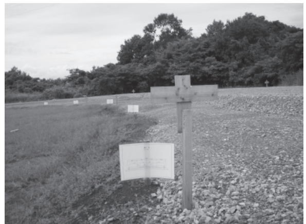
写真-3 実習コースの水糸下がり管理用丁張
