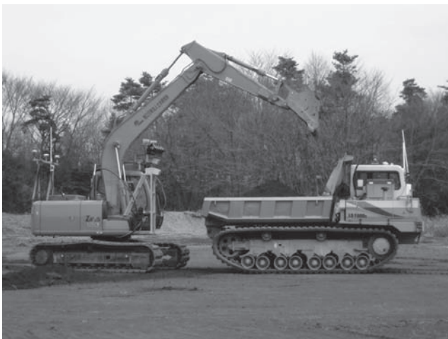
写真一3 自動掘削・積込みの基礎実験状況
