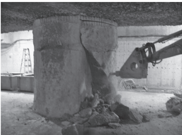
写真—4 油圧ブレーカによる解体
