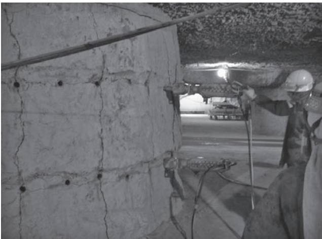
写真—3 ロックジャッキによる解体
