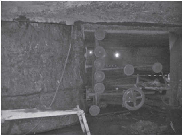
写真—2 ワイヤソーによる解体
