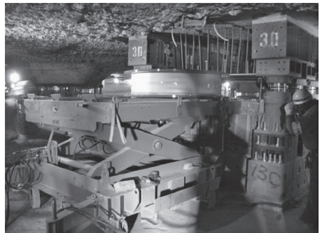
写真—6 免震装置据付
