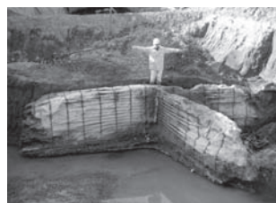
写真—2 口径仕様の3方向改良体
