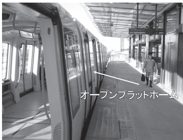
写真一2 コペンハーゲン無人地下鉄(高架部)
