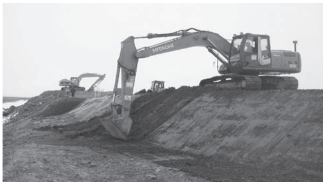
写真-1 ICTバックホウを用いた掘削状況
