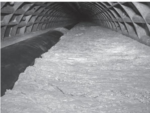
写真一 1 アワモルの流動、充填状況
