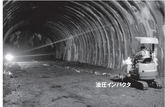
写真-1 トンネル坑内での探査事例 [油圧インパクト震源]
