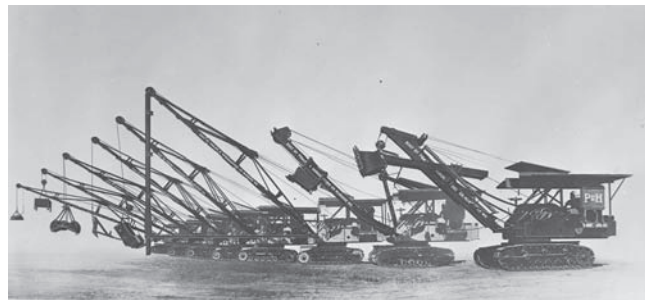
写真-4 P&H社300シリーズ・パワーショベルの9種類のアタッチメント (P&H Mining Equipment社提供写真)
