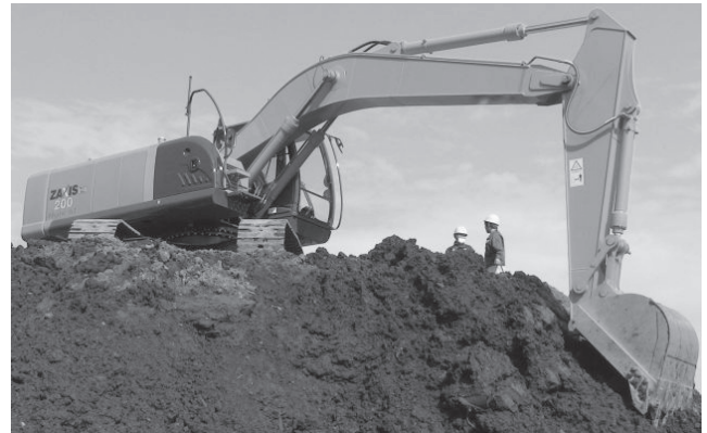
図一11 ハイブリッドショベルの掘削試験状況
