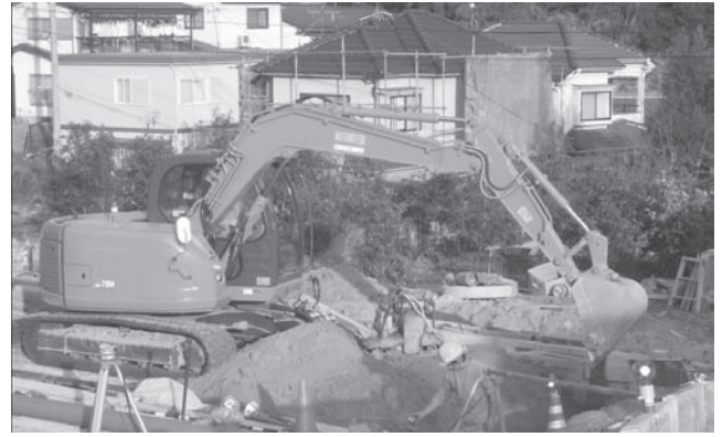
写真一4 稼働状況（宅地造成）
