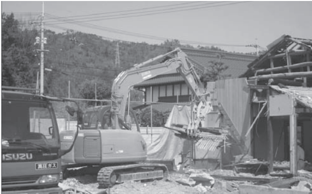
写真一2 稼働状況（家屋解体）
