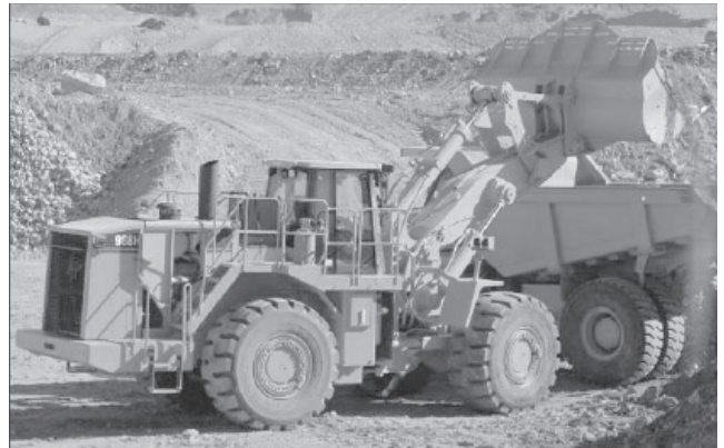
写真—6 トラック積込作業
