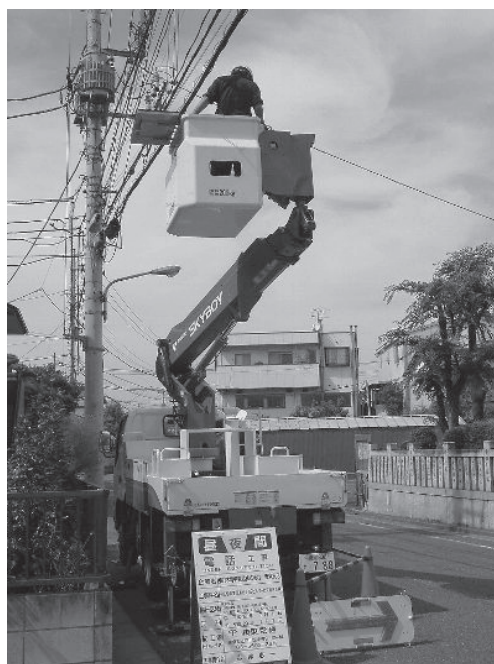
写真—1 光ファイバ接続工事
