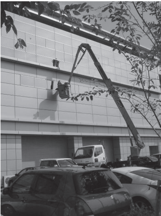
写真-2 窓拭き作業
