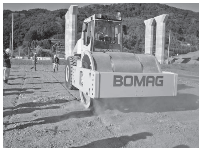
写真—2 25 ton ポリゴンドラムローラによる試験施工 （第二東名高速道路引佐 IC 施工現場）
