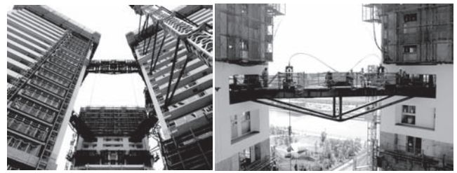
写真-3 リフティングガーダー架設状況
