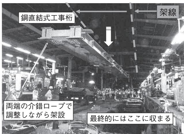
図一五 工事桁設置状況
