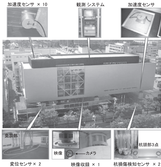
図-3 建物全景と設置センサ
