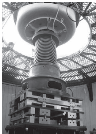
防震装置設置状況 (水の子島：3等)
