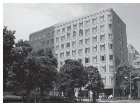
写真—1 建物外観（改修後）
