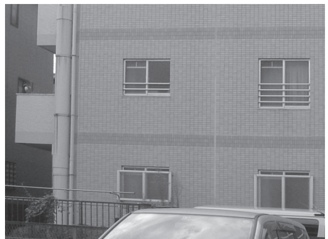
写真一5 可視写真 (タイル張り)
