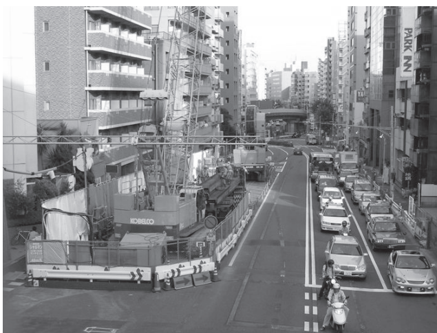
写真一 2 作業帯状況
