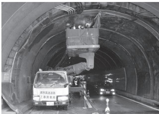
写真一 トンネル坑口補強状況
