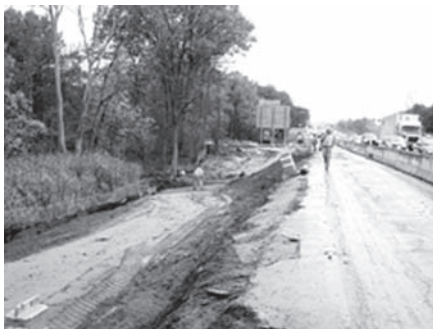
写真3-5 道路幅員拡張現場
