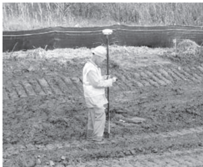
写真3-9 GNSSローバでの出来形計測
