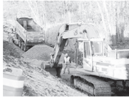
写真3-6 地盤補強シート上に碎石を敷き均す
