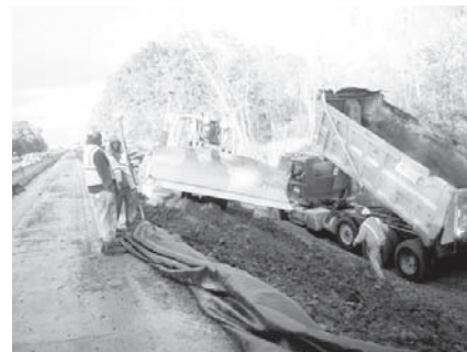
写真3-7 AMGブルドーザでの盛り土工
