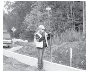
写真 2-3 GPS ローバを用いた発注者による出来形確認
