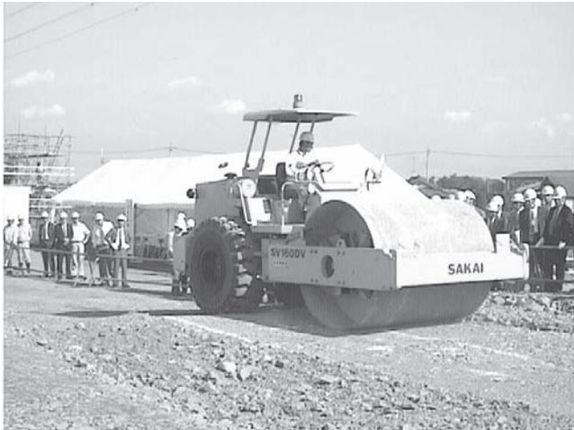
写真一六 300kN 級振動ローラでの厚層施工
