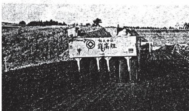
写真—4 タイヤローラによる転圧状況 (ローム)
