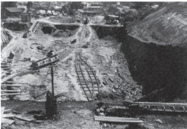
写真—2 横浜新道のディーゼルロコでの施工
