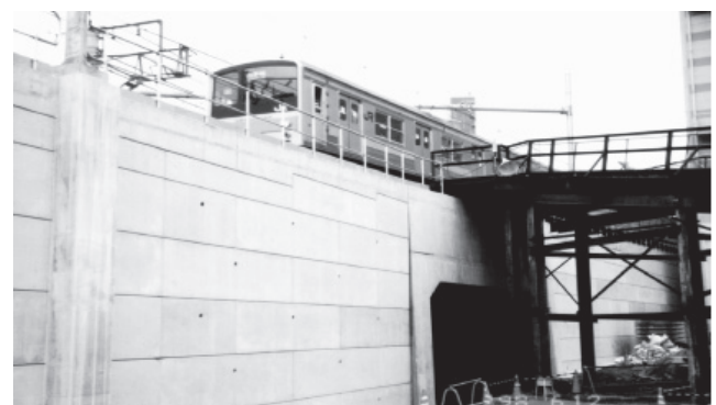
図一九 RRR工法の適用例 15) (山手線, 新宿駅付近)
