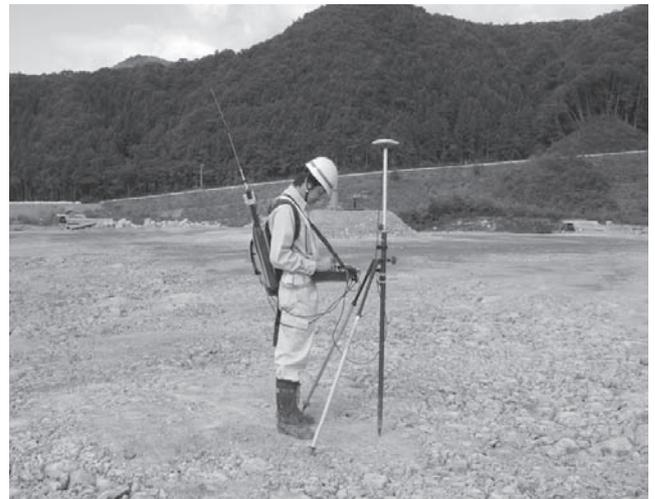
写真-2 3D - Navi による測量状況
