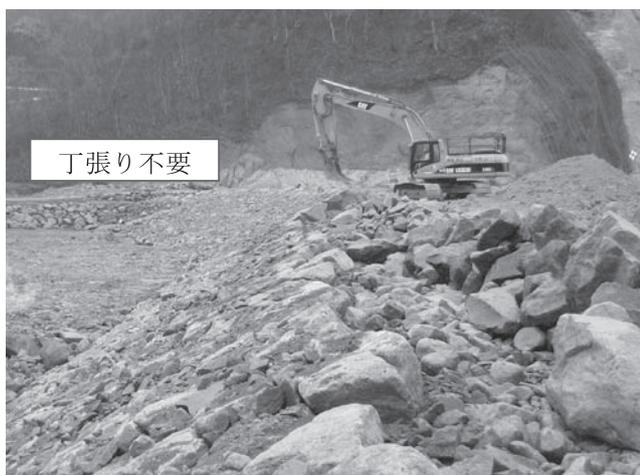
写真一7 下流面リップラップ施工状況
