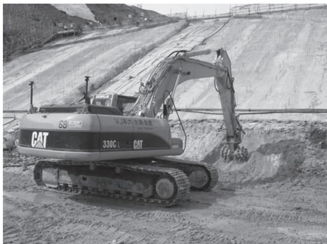
写真一8 仕上げ掘削施工状況
