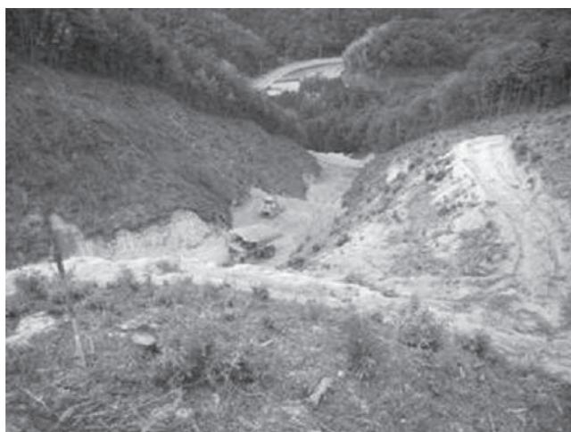
写真一6 重ダンプによる盛土材仮置き状況
