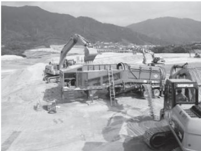
写真一八 チップ材選別機による発生土篩い分け状況
