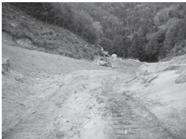
写真一7 ブルドーザーによる仮置き材押土状況
