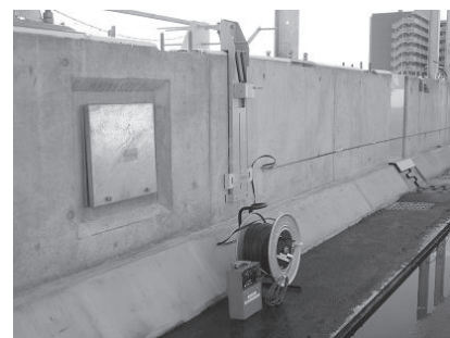
写真一 1 フィーダ線の設置状況
