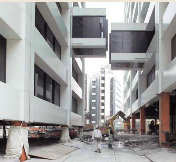
第1棟(左側) ジャッキダウン中
