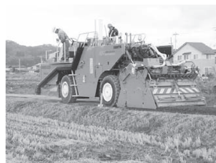
写真—6 農道表面処理施工現場
