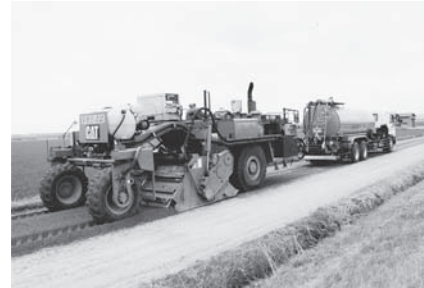
写真—5 秋田県八郎湯大規模農道表面処理施工現場
