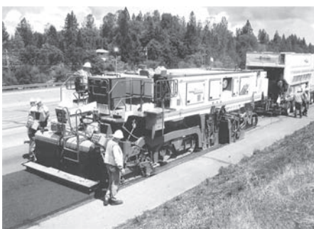
写真—4 敷き均し装置を装着したフォームドスタビライザ
