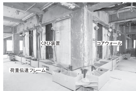
写真一3 コアウォールと荷重伝達フレーム
