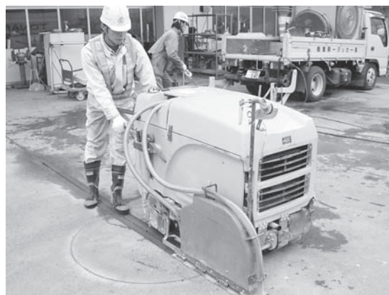
写真－1 フラットソーイング工法
