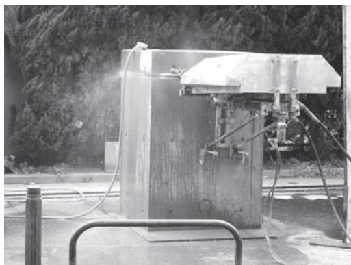
写真一4 ワイヤソーイング工法
