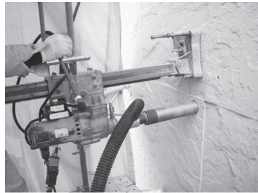
写真—7 乾式コアドリリング工法
