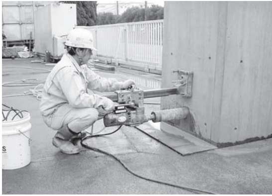
写真一2 コアドリリング工法
