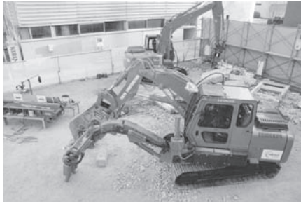
図一 10 実証実験状況
