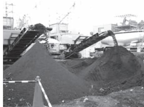
写真一 2 アルミ系固化助剤の混合攪拌状況
