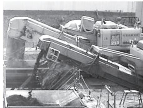
写真一 1 石灰系固化材の混合攪拌状況
