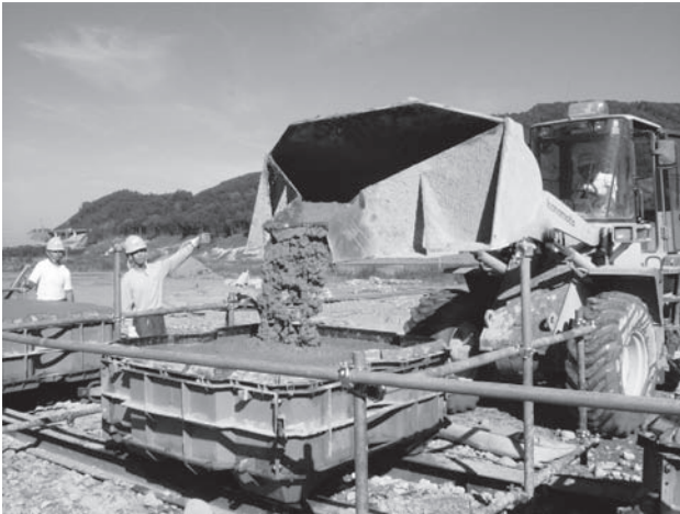
写真一四 ブロックの打設状況
