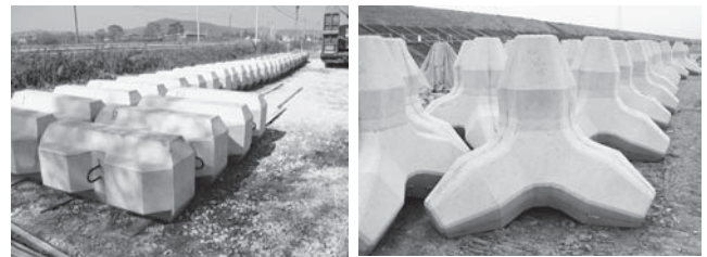
写真—3 ブロックの打設状況
