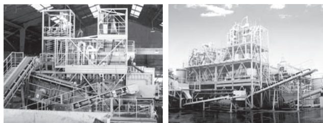
(A) 定置型 洗浄プラント(川崎)
