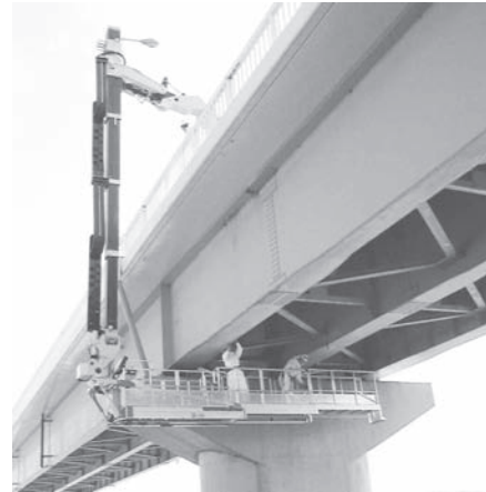
写真一6 足場敷設作業風景
