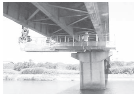
写真一7 橋梁点検作業風景
