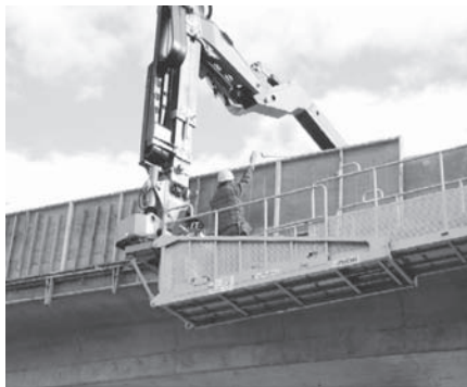
写真一5 高欄工事風景
