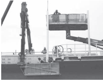
写真一4 遮音壁工事風景
