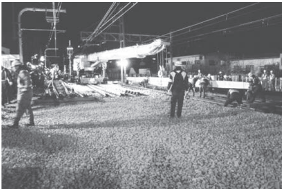
写真-2 鉄道クレーンによる分岐器敷設
