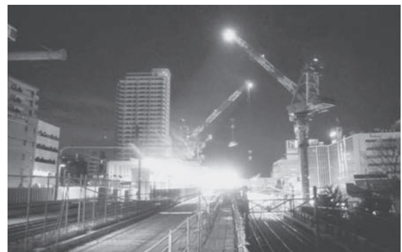
写真-1 タワークレーン稼動状況
