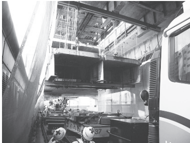
写真-4 撤去状況
