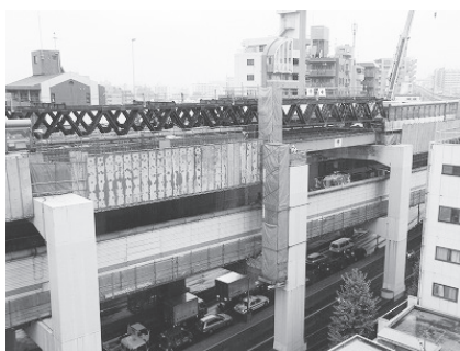
写真—3 架設用トラス桁
