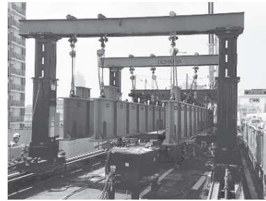
写真-5 リフターによる主桁送り出し状況
