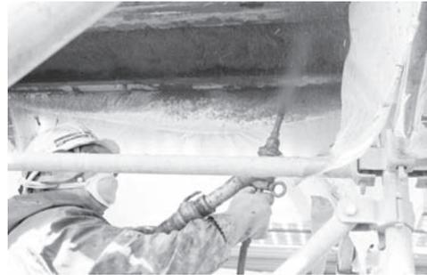
写真一五 吹付けによる断面修復の状況
