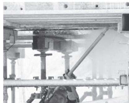
写真一3 ウォータージェットによる脆弱部のはつり状況
